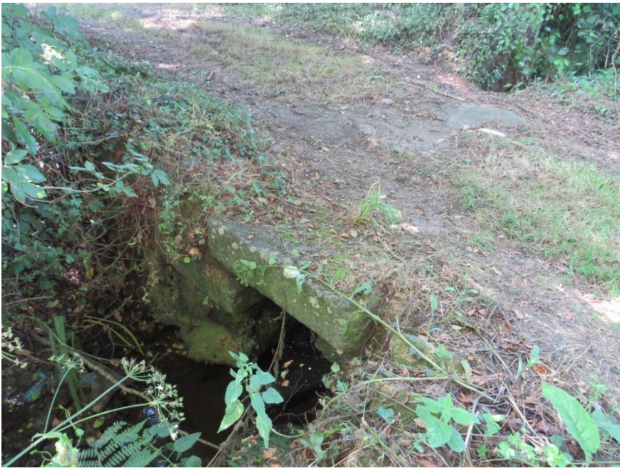
Pontella no interior do ámbito do PIA. Traballo de campo do PIA.
