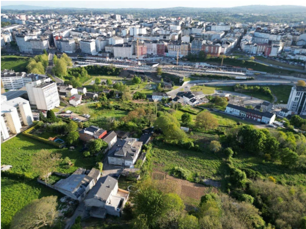
Na parte inferior esquerda da imaxe apréciase o núcleo de Burozón, na parte central a construción da estación Intermodal e ó fondo o centro da cidade de Lugo
